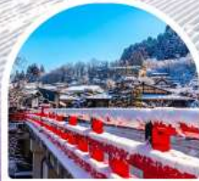
สะพานนากะบาชิ
